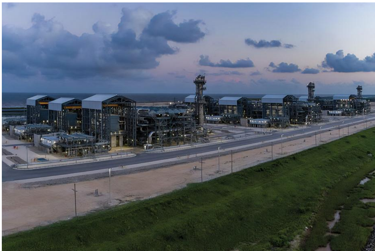
Freeport LNG facility in Texas. Freeport LNG/AP
